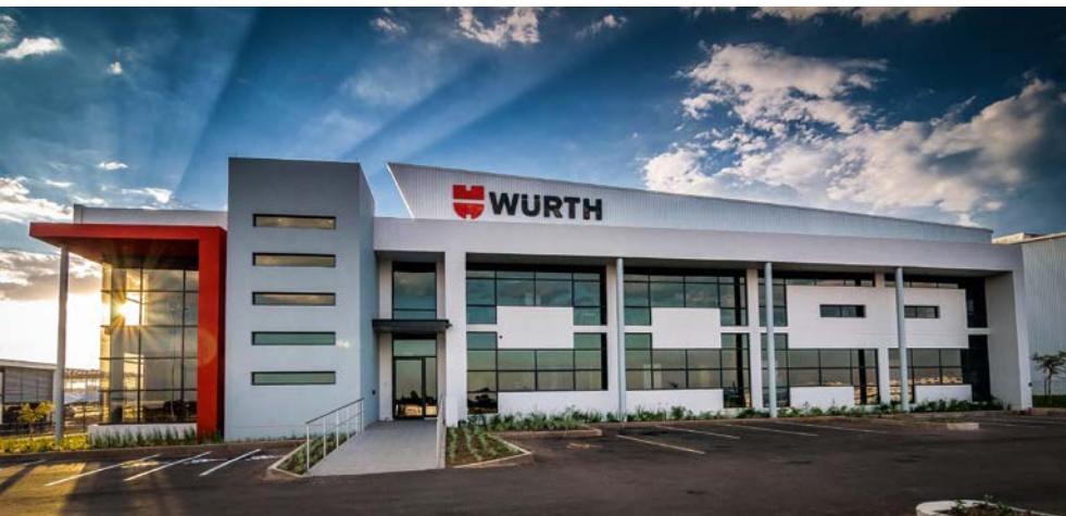
Wuerth South Africa (Pty.) Ltd. en Gauteng, Sudáfrica
